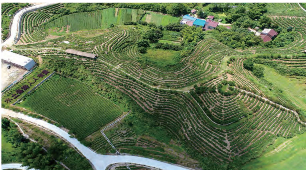
图8 黄冈市英山县闻家冲小流域水土流失综合治理工程
